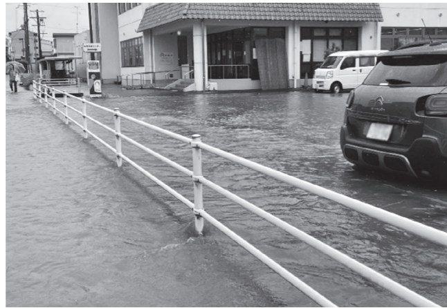
▲今年7月19日の大雨で西庁舎周辺が冠水した様子
