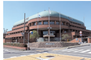
▲市役所東庁舎
