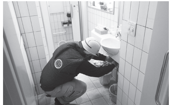
▲修繕工事の様子
