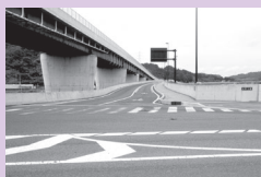
▲国道1号石部大橋
