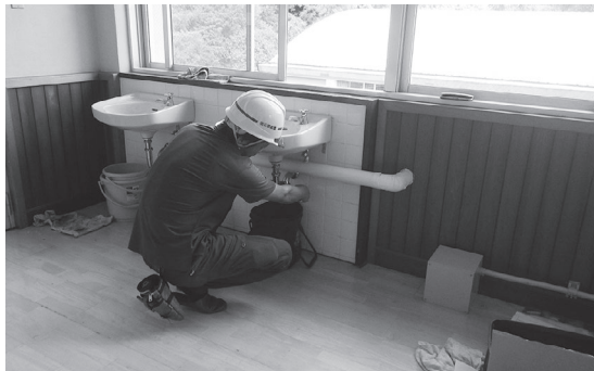
▲修繕工事の様子
