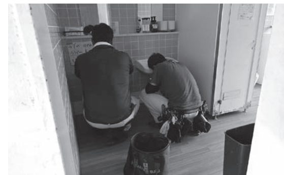
▲修繕工事の様子
