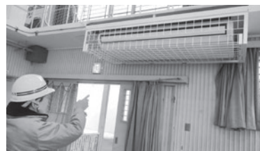
▲災害対策施設整備工事の様子
