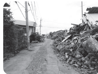
平成28年4月熊本地震 (平成28年6月に撮影) ▶
