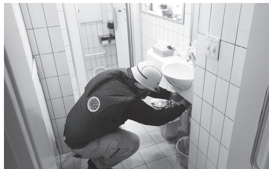
▲修繕工事の様子
