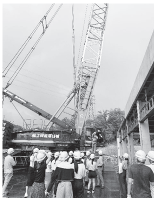
▲石部緑台の建設現場見学の様子
