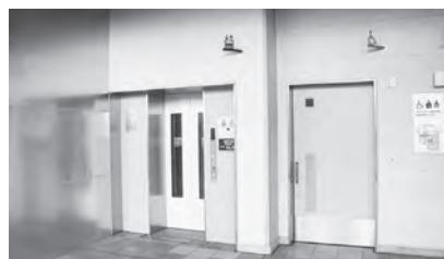
新設した石部駅のエレベーターと多目的トイレ
