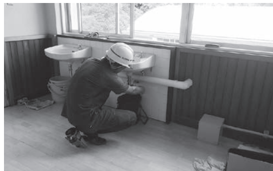
▲修繕工事の様子
