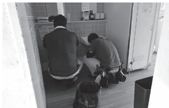
▲修繕工事の様子
