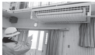
▲災害対策施設整備工事の様子
