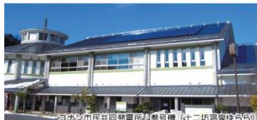
コナン市民共同発電所 参号機 (十二坊温泉けらら)
