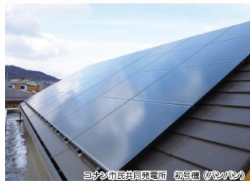
コナン市民共同発電所 初号機 (パンパン)
