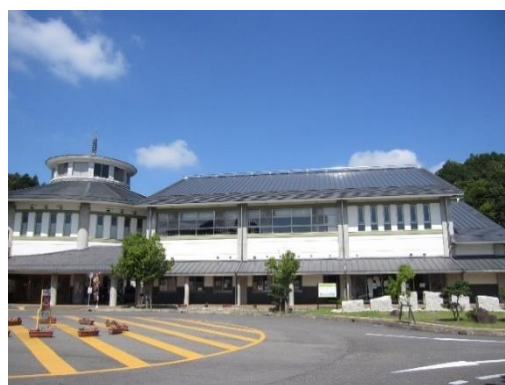
参号機 十二坊温泉ゆらら発電所
