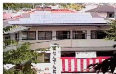
市民共同発電所 「石部・てんとう虫一号」 出典：太陽光・風力発電トラストホームページ
