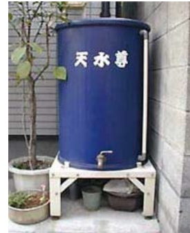
墨田区内で作られている雨水タンク「天水源」 出典:墨田区ホームページ
