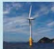
洋上風力発電施設
