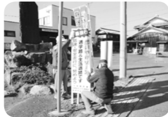
▲立て看板の設置
