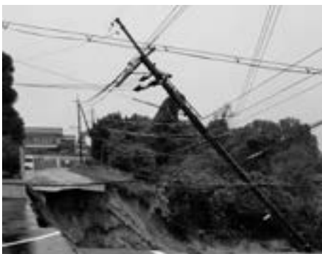
▲陥没した道路(岩根地先)
