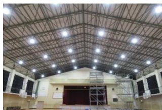
【中学校体育館へのLED照明導入】
