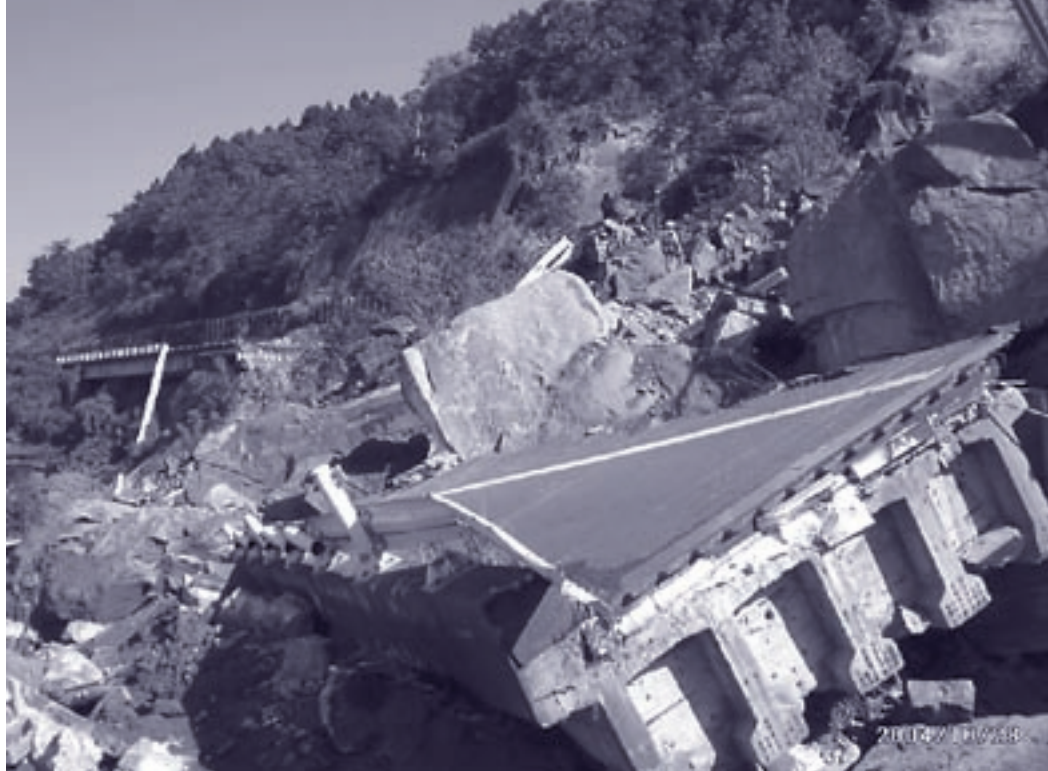
長岡市妙見町で起きた土砂崩れ
