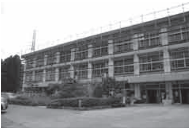
▲石部南小学校耐震・大規模改造工事
