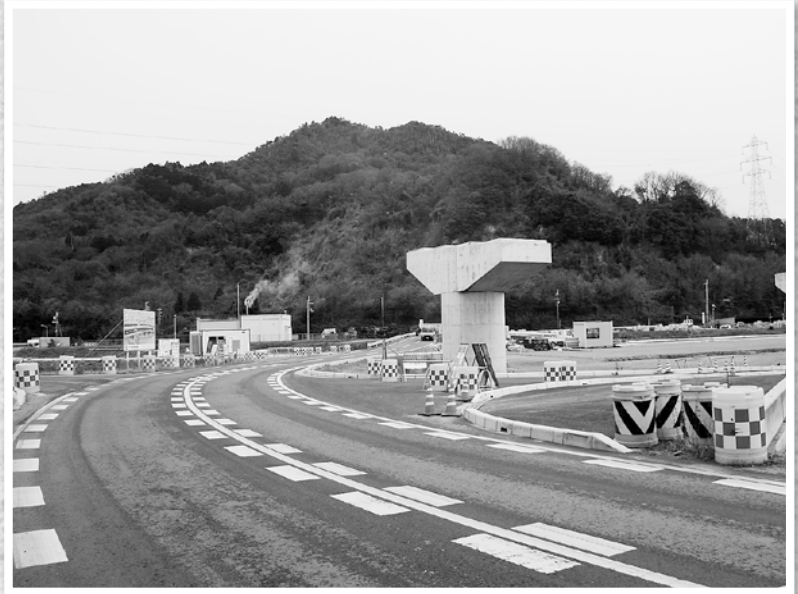
平成20年3月 国道一号バイパスの暫定供用が開始。現在も菩提寺と石部西の間の野洲川に橋をかける工事が続けられています。
