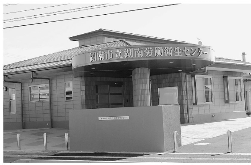
平成18年4月 老朽化した湖南労働衛生センターをリニューアルオープン。
