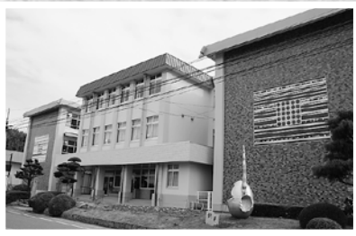
平成20年11月 下田小学校の耐震工事が完了。市内学校の耐震工事は着々と進んでいます。
