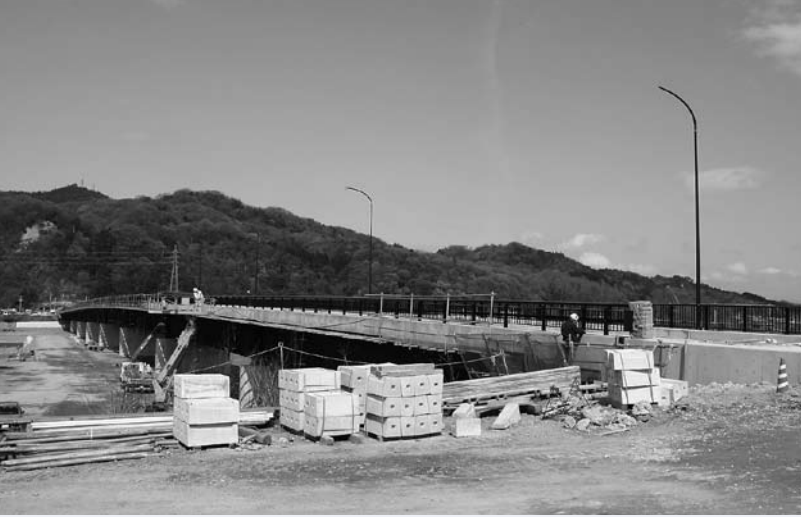
▲6月に開通する新甲西橋
