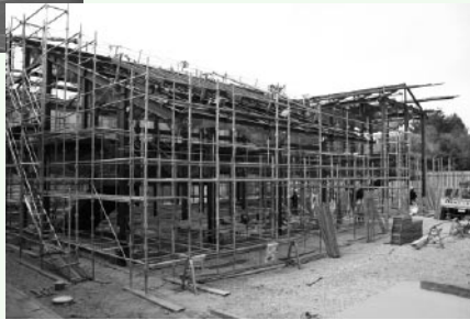
▼増築中の水戸小学校校舎
