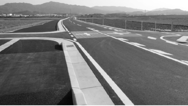
▲市道野神8号線道路改良工事
