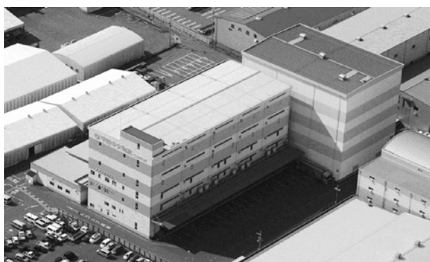
▲式号機が設置される甲陸中央物流センター
