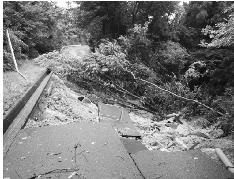
▶道路の崩落 (針地先)
