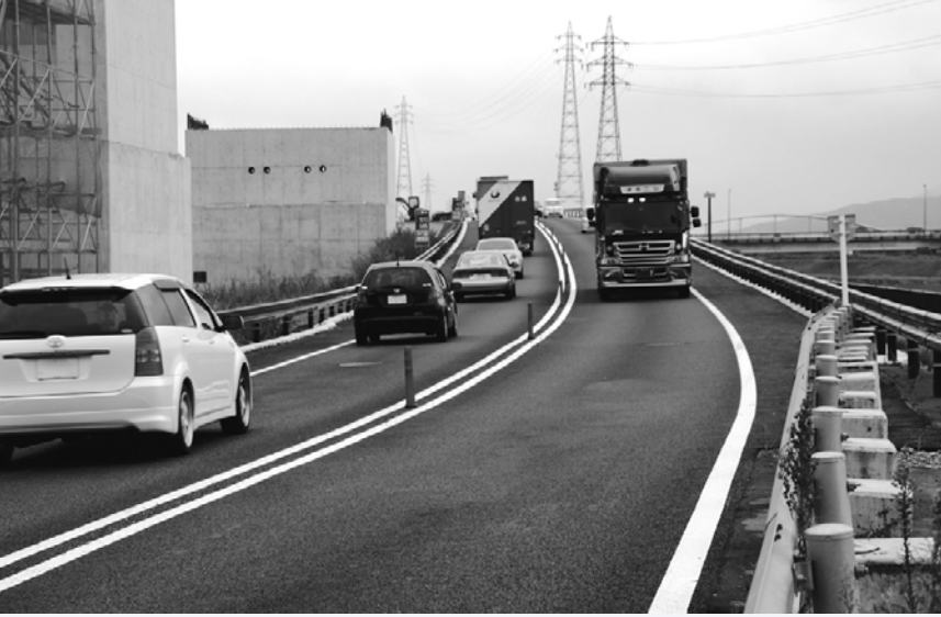
▲平成20年3月 国道1号バイパスが岩根から菩提寺まで開通しました。
