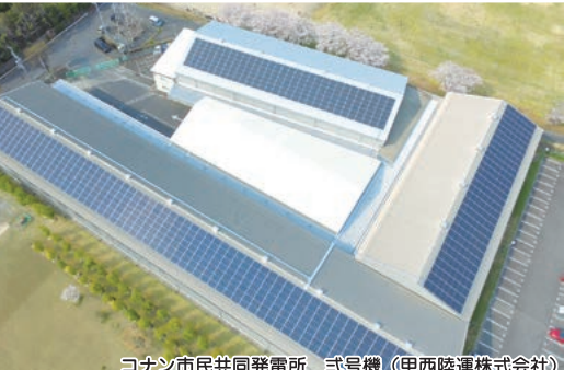
コナン市民共同発電所 式号機 (甲西陸運株式会社)
