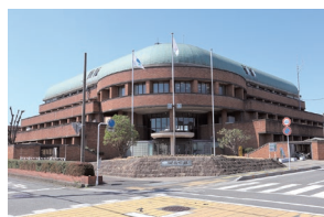
▲市役所東庁舎
