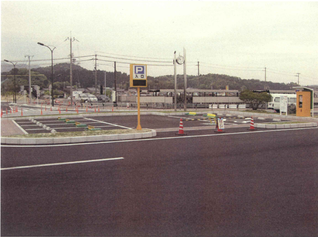
甲西駅南口自動車駐車場
