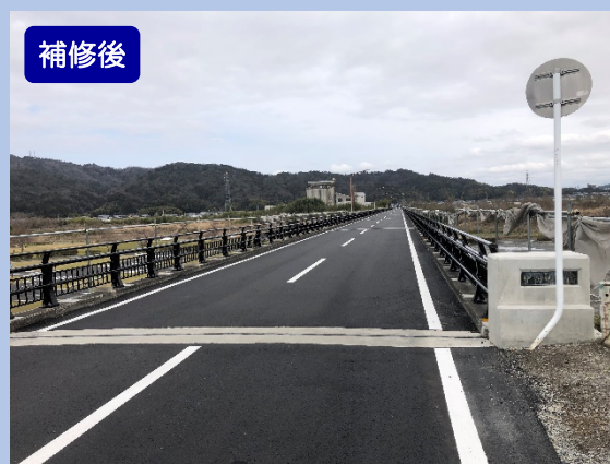
甲西中央橋（令和2年度補修）
