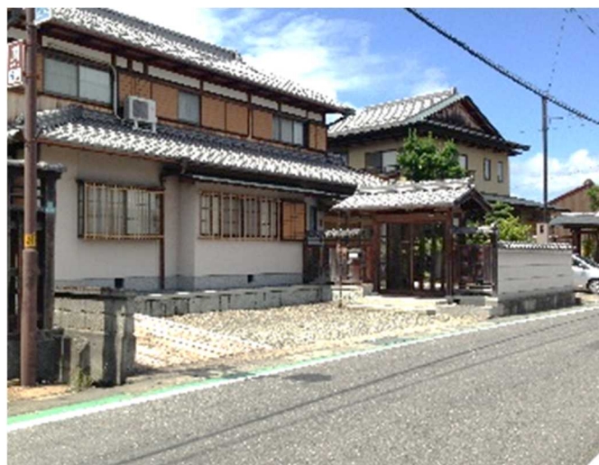
旧東海道に面して駐車スペースを確保しながらも、門や塀の設置により、通りの連続性に配慮している例
