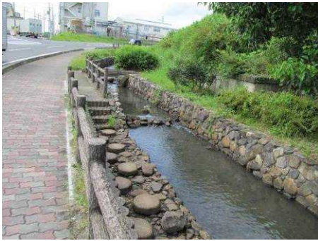
自然石を護岸に用いるなど、風景の中に馴染むような素材で仕上げる
