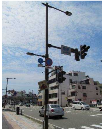
信号機、標識、街路灯を一体化し、市中の乱立を防止（木田橋通り（福井県福井市））
