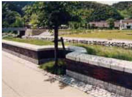
石州瓦を埋め込んだパラペットによる嵩上げ（津和野川（島根県）） （出典：河川景観の形成と保全の考え方 参考資料国土交通省）
