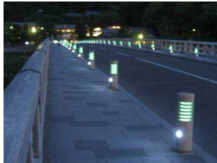
歴史的な街並みに配慮し、防護柵を利用して趣のある照明を導入（渡月橋（京都市））
