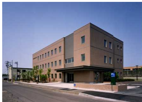
落ち着いた色彩で全体をまとめている （北海道 室蘭法務総合庁舎）
