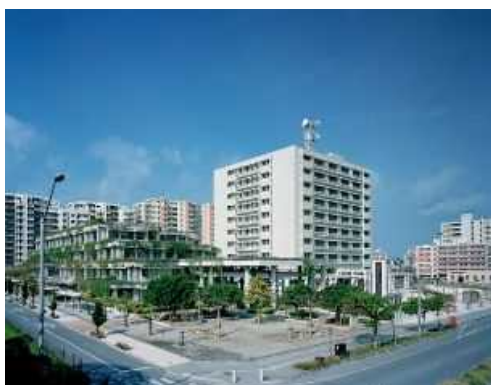
歩道と一体となった緑化、建物緑化 (沖縄県 那覇第2地方合同庁舎)
