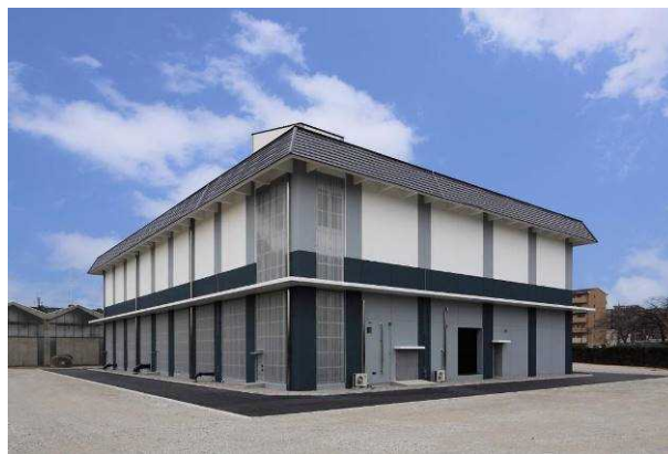
周辺の景観に配慮し、プラント的なイメージを避けたポンプ場 (京都市)
