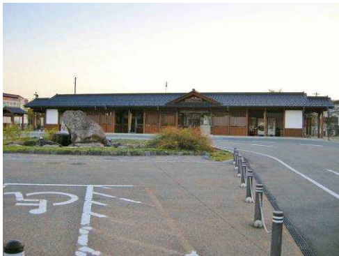
湧水と城下町の歴史に配慮した 駅舎と駅前広場のモニュメント (越前大野駅 (福井県大野市))
