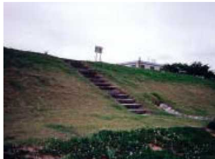
景観に配慮し、階段に鉄道の枕木を利用 (阿武隈川(福島県))
