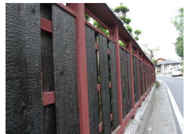
焼杉板の塀の例
