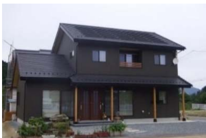
屋根の形状・色彩との一体感に配慮したソーラーパネルの例
