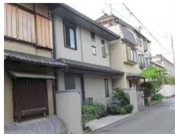
1 階に軒庇を設けることで、家並の連続性に配慮している例
