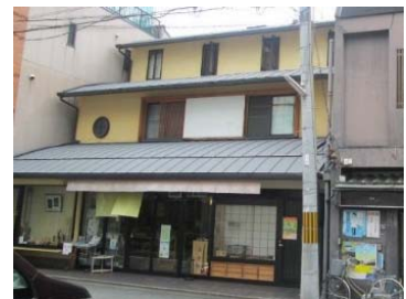
1 階、2 階に軒庇を儲け、3 階部分の壁面線を後退させている例
