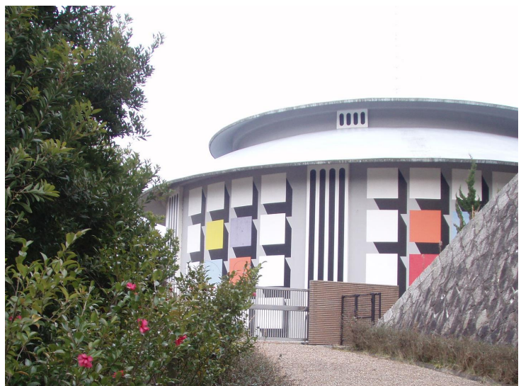
雨山低区配水池
