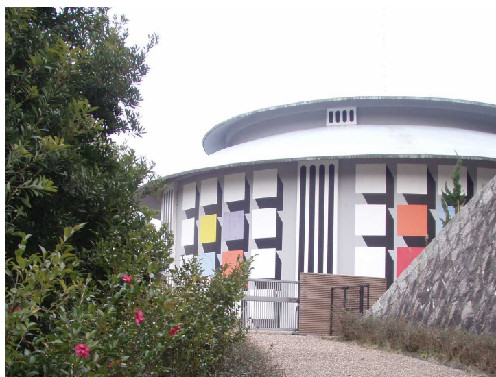
雨山低区配水池
