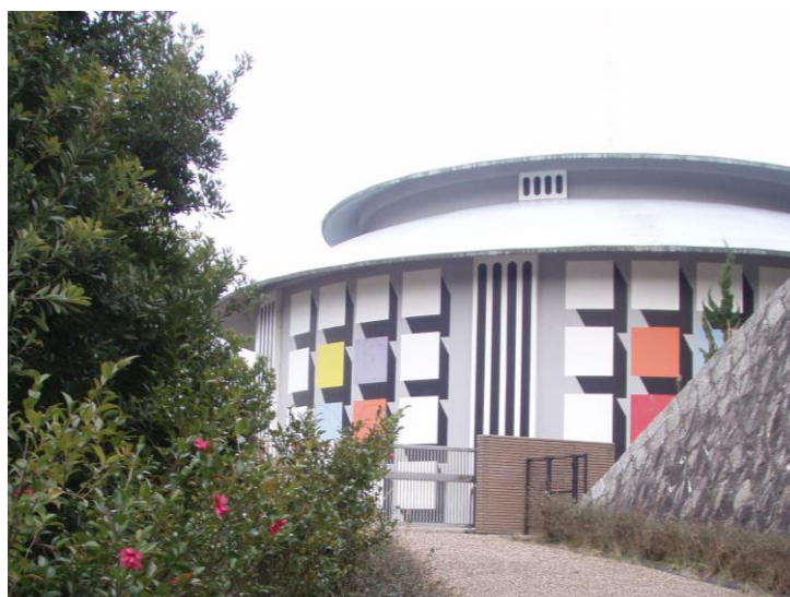
雨山低区配水池
