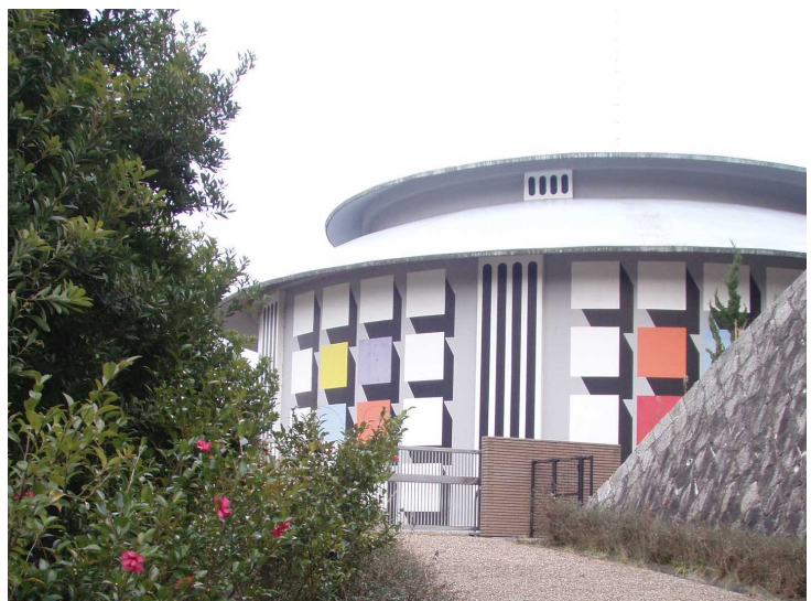
雨山低区配水池
