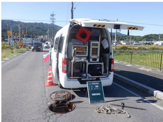
下水道管の状態を確認するカメラ調査風景
