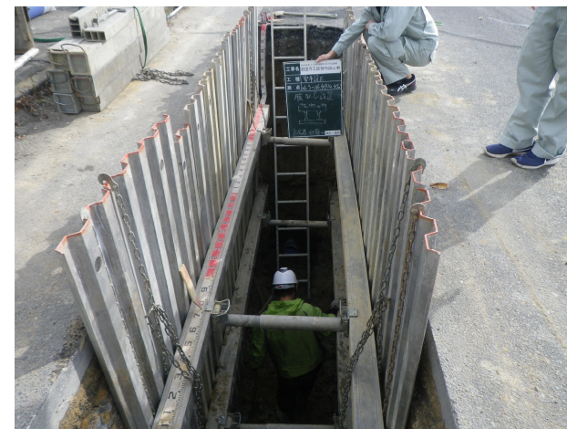
新たな下水道管渠を布設する工事の様子
