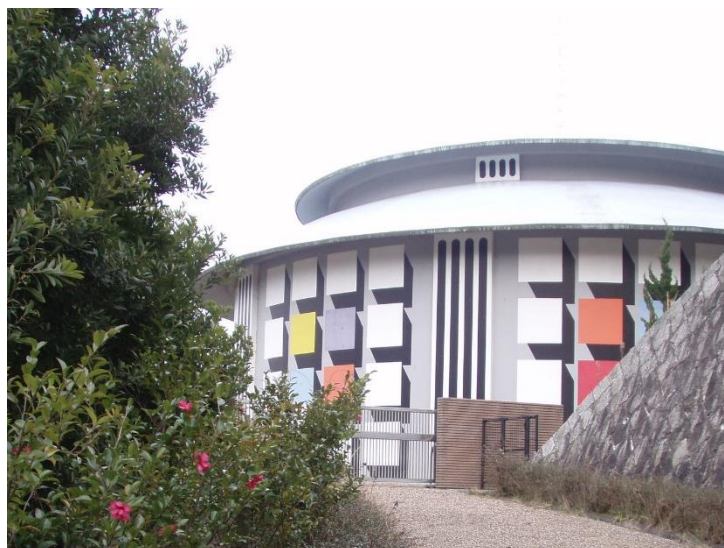
雨山低区配水池
