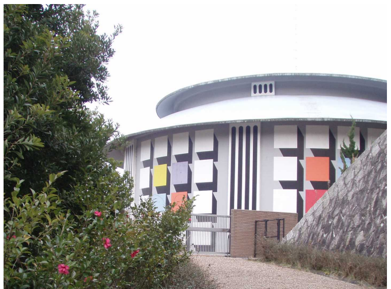
雨山低区配水池
