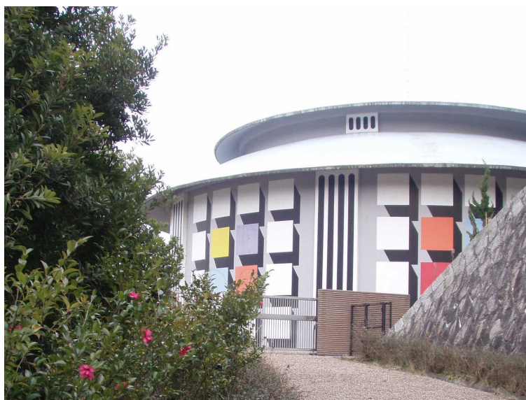
雨山低区受水池(配水池)
