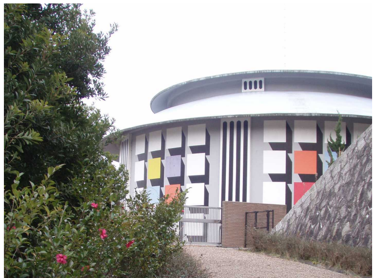
雨山低区受水池(配水池)
