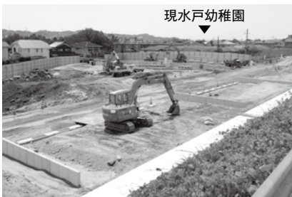
造成工事中の第3工区
