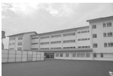
改築された甲西中学校
