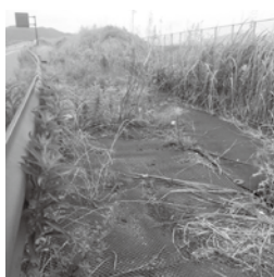
国道1号バイパス横の現状
