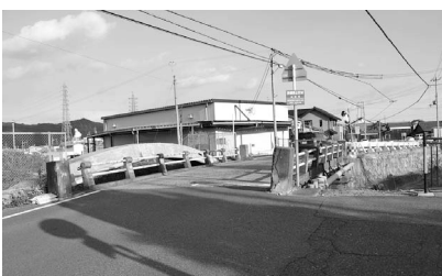
老朽化する落合川橋
