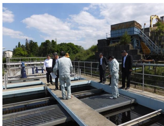
△東河原浄水場
