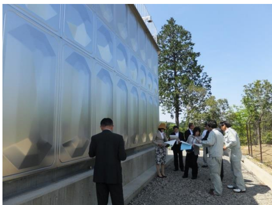
△雨山高区配水池
