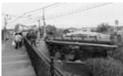
拡幅が望まれる落合川橋
